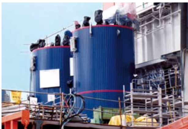
▲ Fig. 1: 据付中のMISSION™ OL型ボイラ 2 缶 (韓国の造船所にて)
