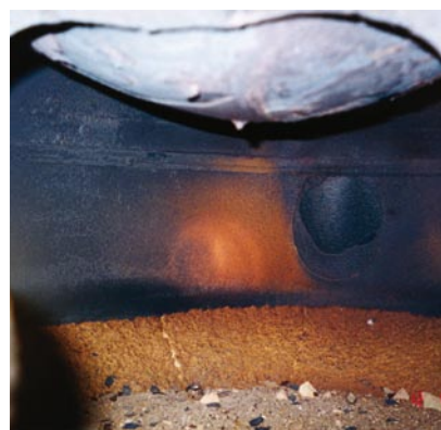
燃油蒸汽锅炉中油液污染造成的后果
